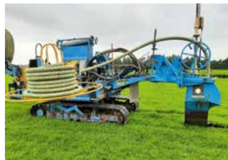
Aanleg van drains van het infiltratiesysteem
